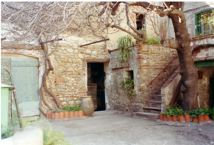
Extérieur du moulin en 2001
